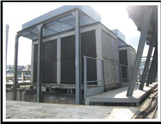
Non office hour chiller
